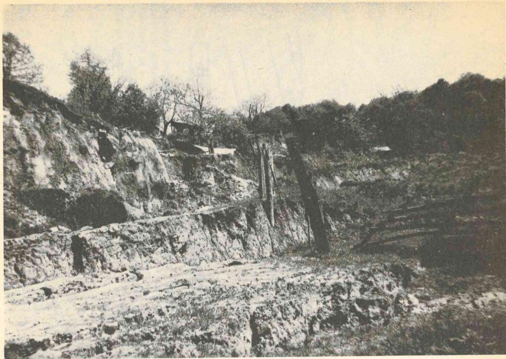
Рис. 4. Фрагмент стенки срыва оползня Стерч-Керч. Катастрофическая фаза развития структурно-тектонических (блоковых) оползней, приуроченных к зонам поперечных разломов
